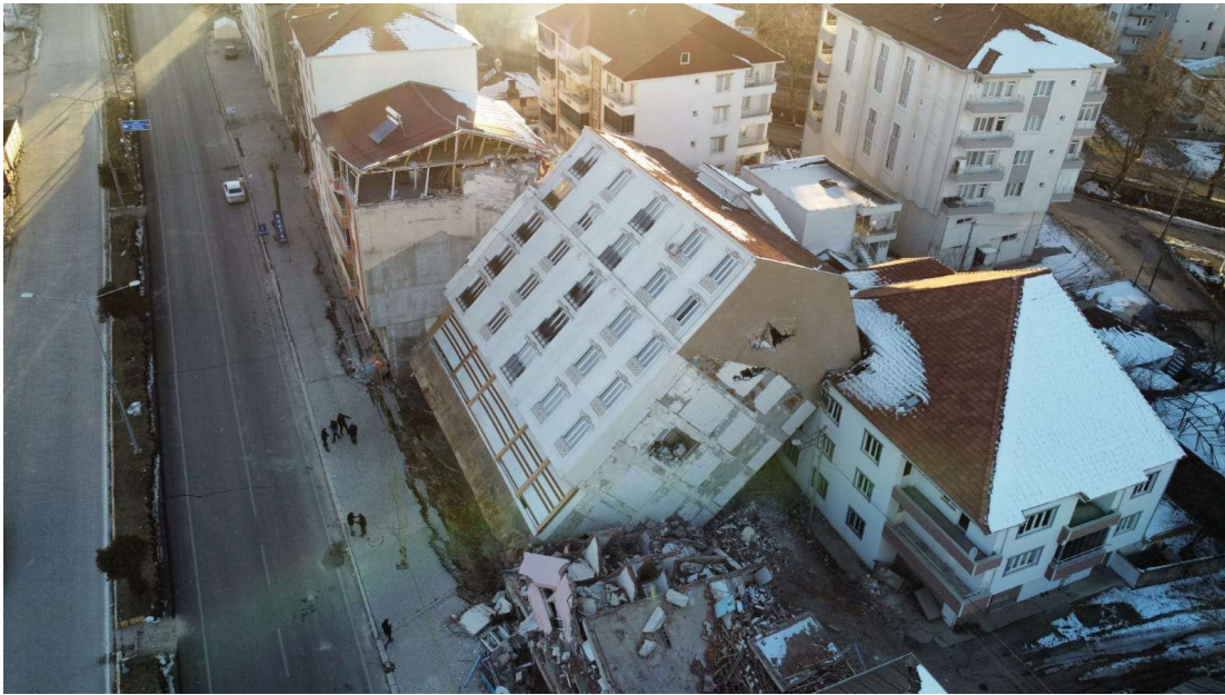
Şekil 3.7 : Gölbaşı, Adıyaman’da temellerde gözlemlenen problemler
