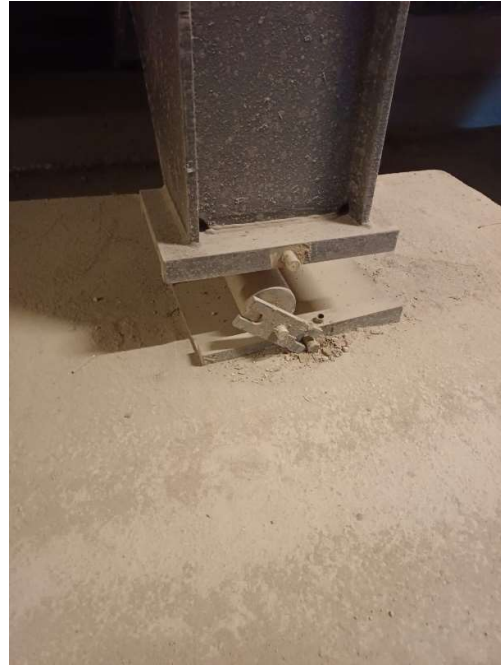
c) Boru desteğinde meydana gelen hasar
