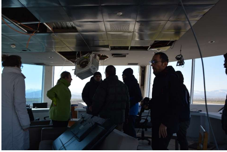
a) Kule yapısında meydana gelen yapısal olmayan hasarlar
