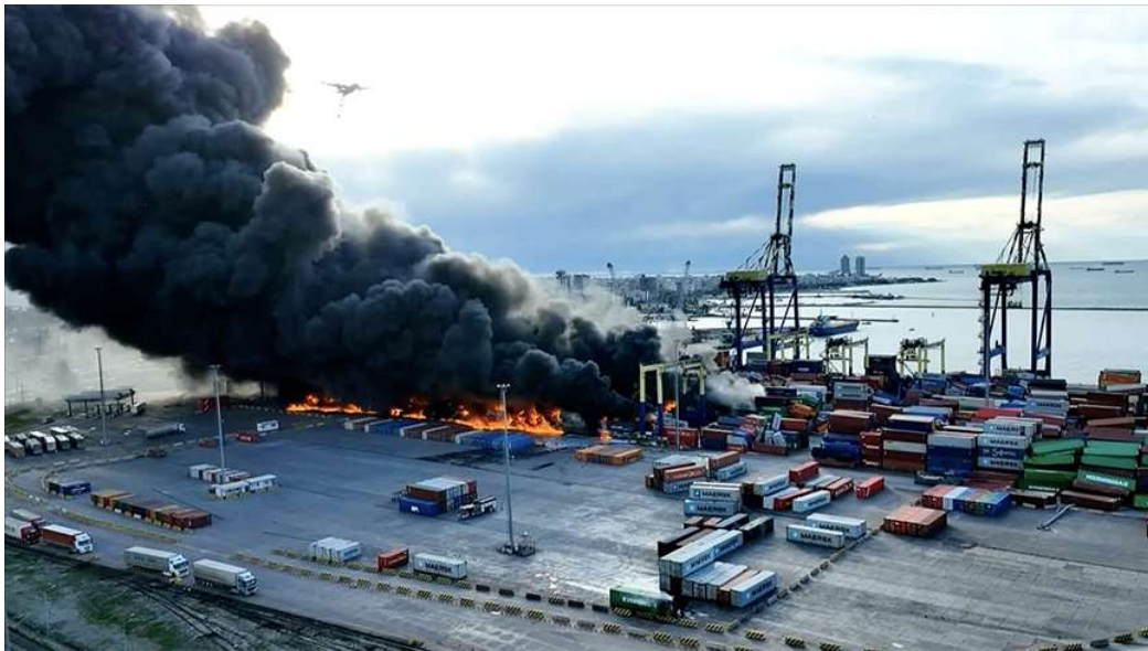
Şekil 4.16 : İskenderun Limanı deprem sonrasında çıkan yangın
