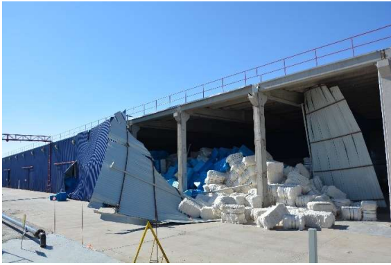
Şekil 4.14 : Kahramanmaraş'ta bir tekstil işletmesinde görülen yapısal olmayan elemanlara ait hasarlar ( dış cephe kaplaması hasarı ve makine-teçhisat hasarı )
