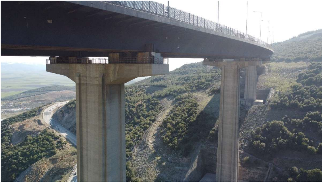
Şekil 5.5 : TAG Otoyolunda tabliye, ayak ve mesnetlerinde hasar gözlemlenmeyen bir Viyadük
