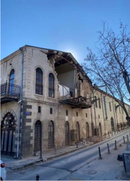
Şekil 4.12 : Geleneksel yığma yapılarda oluşan hasarlar
