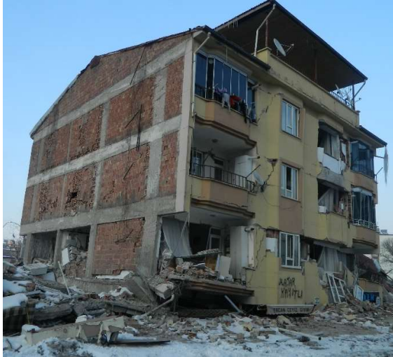
Şekil 4.4 : Yumuşak/zayıf kat olarak gözlemlenen tasarım problemi
