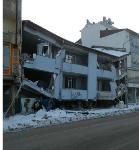
Şekil 4.4 : Yumuşak/zayıf kat olarak gözlemlenen tasarım problemi
