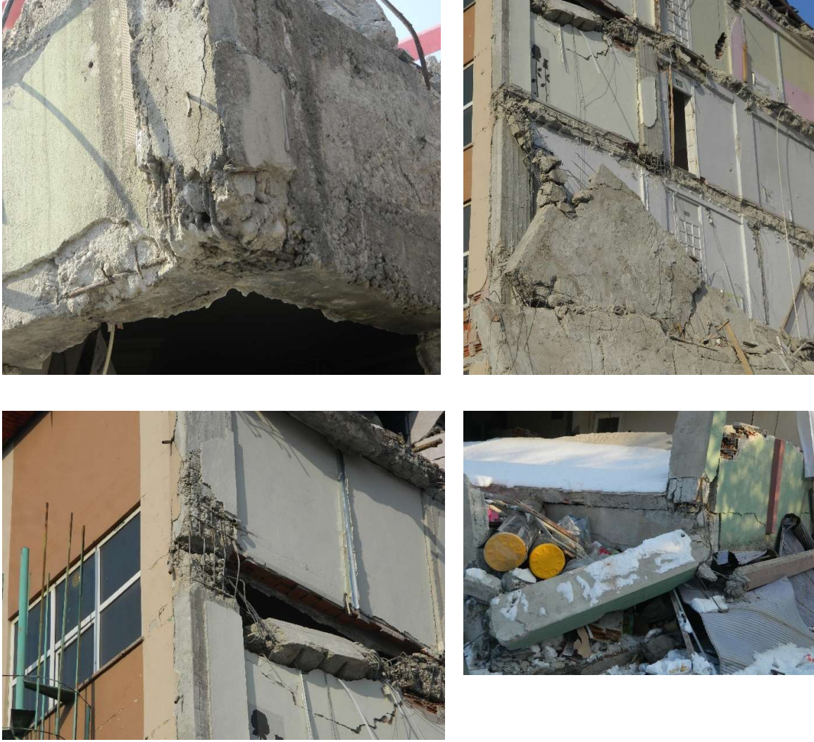
Şekil 4.1 : Mevcut beton kalitesinde gözlemlenen problemler ve düz yüzeyle beton çeliği mevcudiyeti
