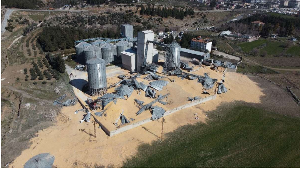
Şekil 4.15 : Gaziantep Nurdağı’da mısır ve buğday siloları hasar gören bir gıda işletmesi
