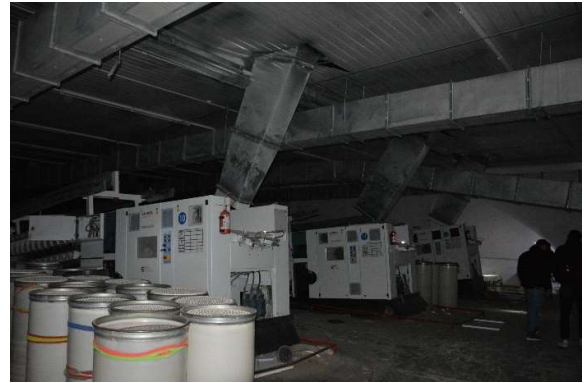
Şekil 4.14 : Kahramanmaraş'ta bir tekstil işletmesinde görülen yapısal olmayan elemanlara ait hasarlar ( dış cephe kaplaması hasarı ve makine-teçhisat hasarı )
