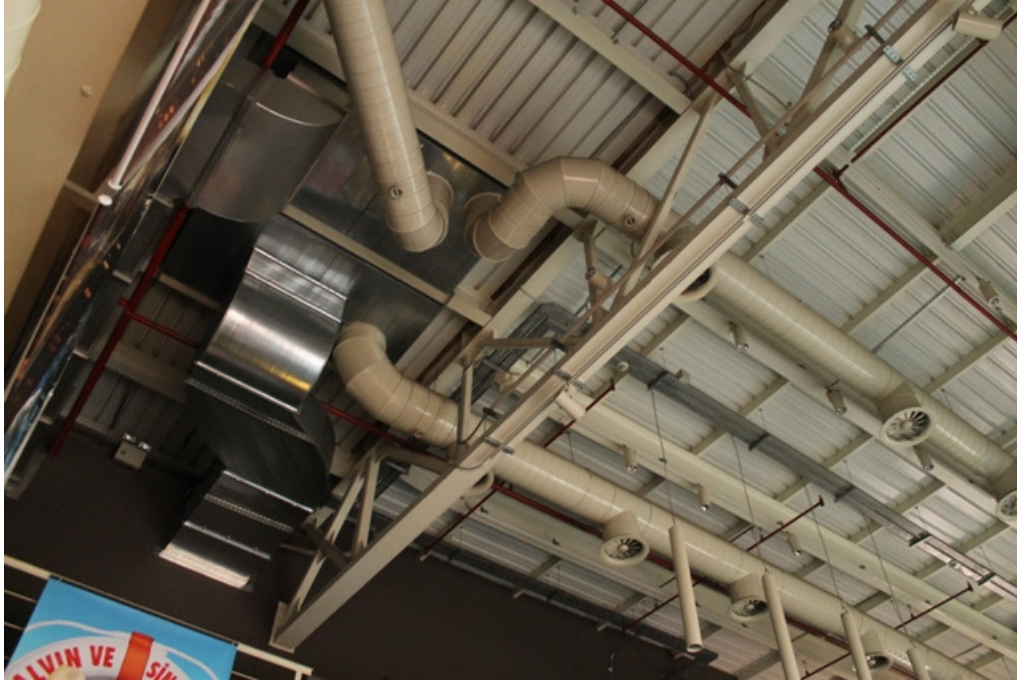
Resim 4: Tesissat ve havalandırma ile ilgili detaylar
